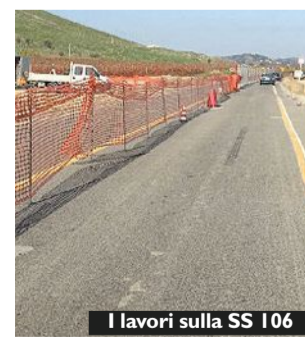
I lavori sulla SS 106
